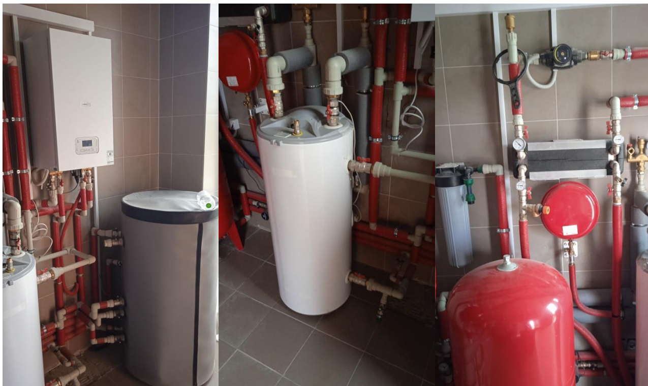
Система гарячого водопостачання будинку
